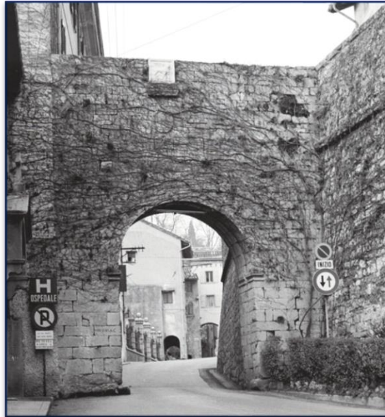
La porta prima del restauro
